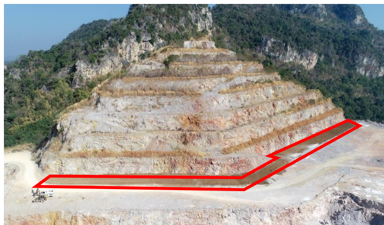
ภาพที่ 1 แสดงพื้นที่ที่นำดินมาถมเตรียมพื้นที่สำหรับการปลูกต้นไม้
